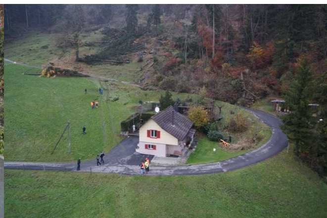
Abb. 10: Im oberen Teil dieses Luftbildes sieht man die Rutschung. Das wenige Meter davor liegende Wohnhaus musste evakuiert werden.
