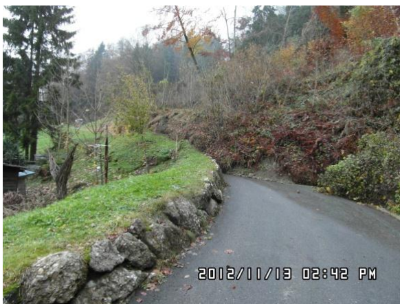
Abb. 9: Die Tannenbergrutschung wälzt sich über die Straße und wird von einem Schutzdamm aufgehalten.
