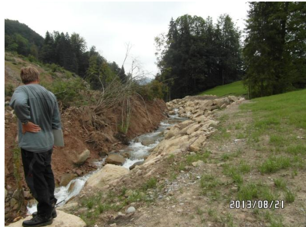
Abb. 10: Verbauung des (orographisch gesehen) rechten Ufers mit Blöcken zur Verhinderung der Ufererosion.
