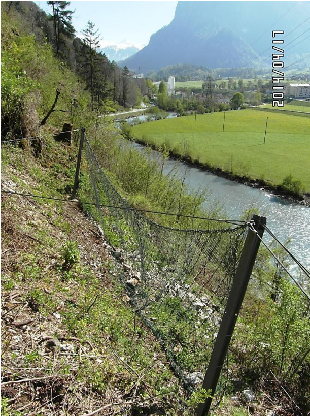
Die bestehenden Steinschlagnetze reichen nicht aus, um die Strasse vollständig gegen Sturzprozesse zu schützen.
