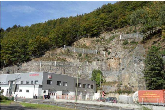
Das Areal unter dem ehemaligen Steinbruch nach Erstellung der Schutzbauten. Der Wandfussbereich ist geschützt und kann wieder gefahrlos genutzt werden
