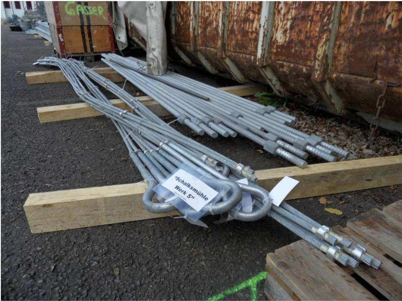
Ausschnitt der angelieferten Bauteile für die Erstellung der Verankerungen (Bild: Seil- und Stabanker)
