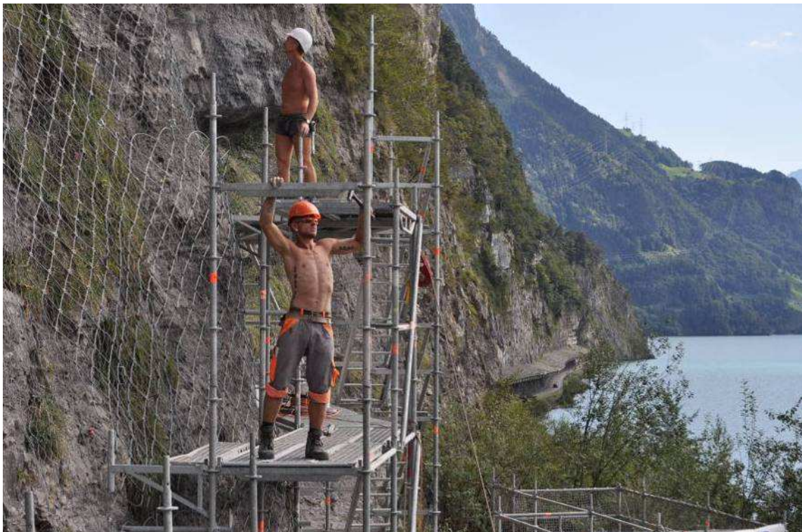
Rückbau des Arbeitsgerüsts der Etappe 2.
