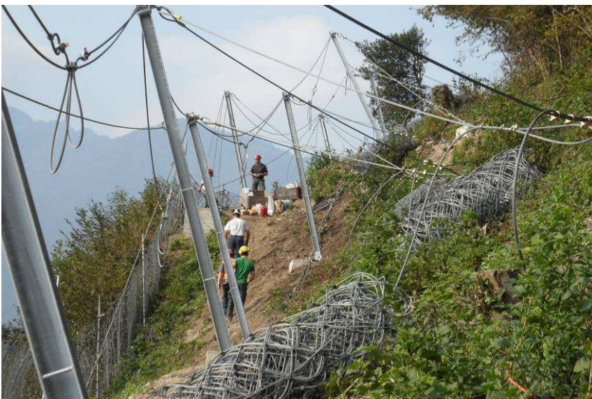
Bauarbeiter der Waser-Forst AG bei der Montage der 1000-kJ Steinschlagschutznetzanlage oberhalb der Bahnlinie.
