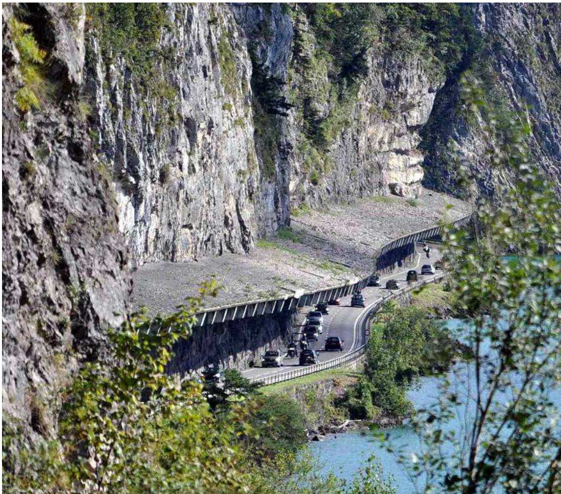
Blick von der Baustelle nach Süden auf die mehrere Hundert Meter lange Galerie Ölberg-Schiferenegg-
