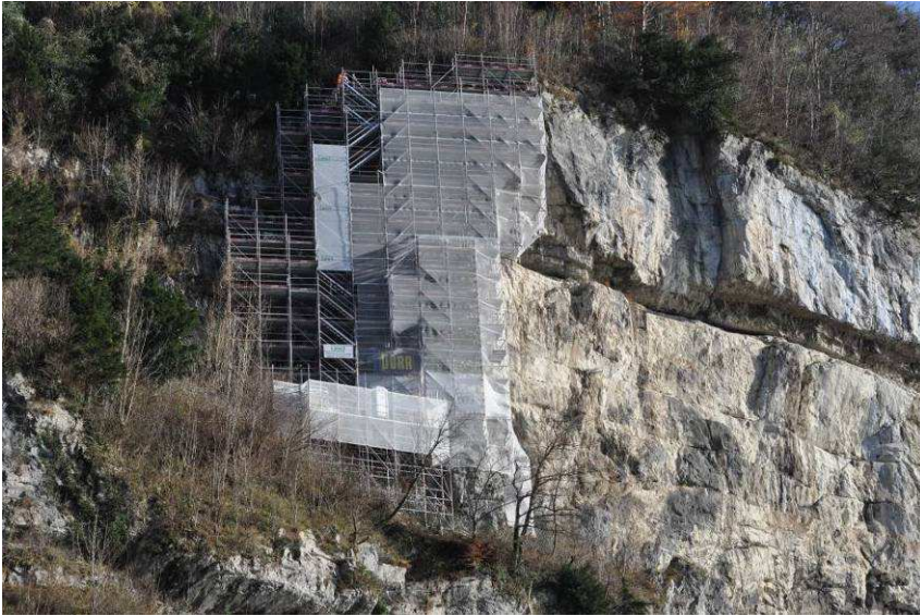
Blick hinauf in den Arbeitsbereich der Etappe 1.
