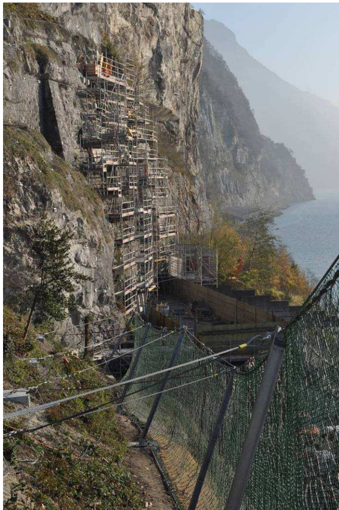
Baugerüst Nordportal SBB-Ölbergtunnel.
