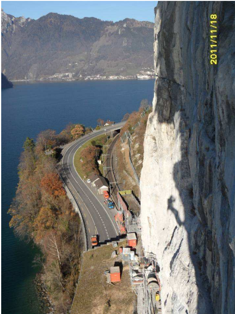
Festlegung von künftigen Überwachungsstellen am hängenden Seil.
