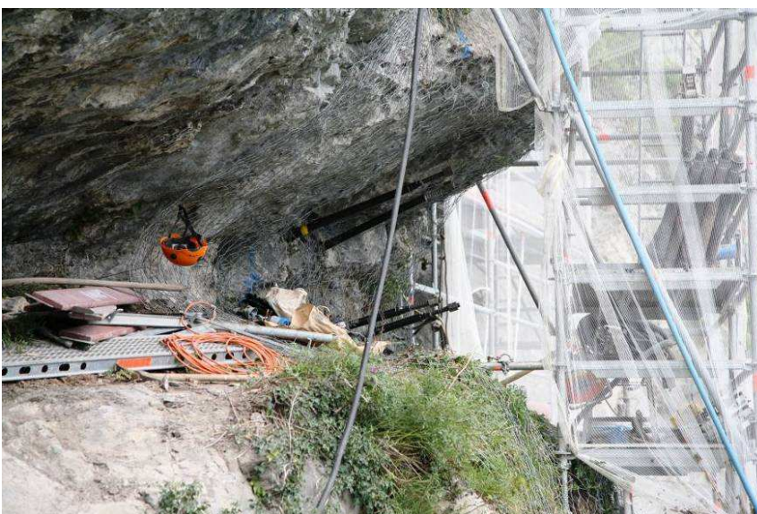
Zur Rückverankerung der Betonunterfangungen wurden vorinjizierte Felsanker verwendet.
