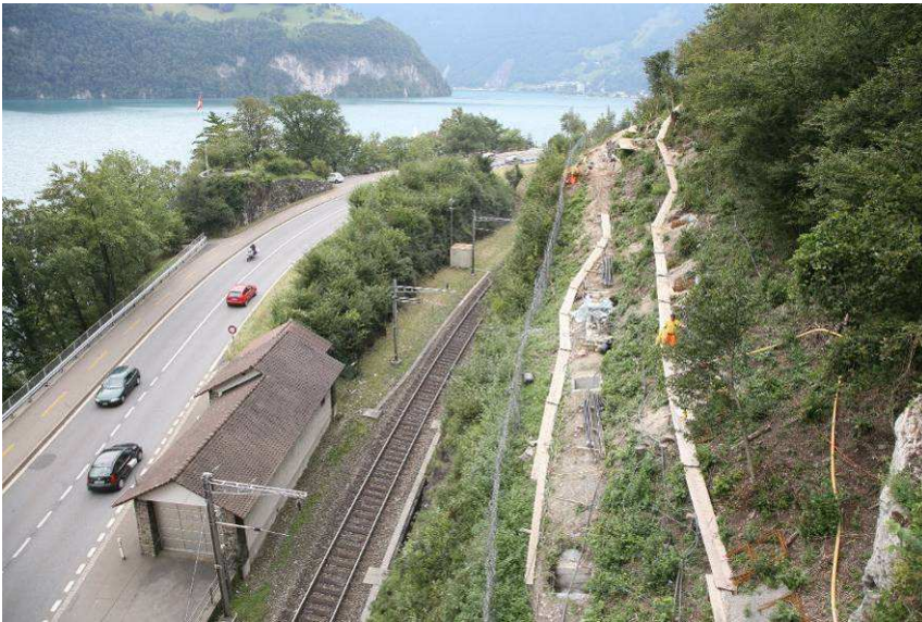
Baupiste für das untere der beiden 1000-kJ Steinschlagschutznetze, wenige Meter oberhalb der Bahnlinie.
