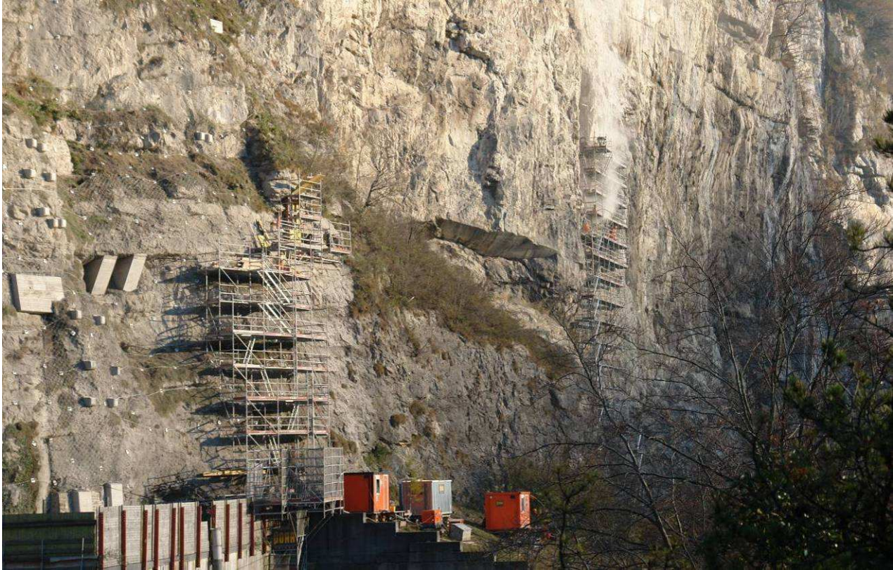
Links: Baugerüst Nordportal SBB-Ölbergtunnel. Rechts: Baugerüst ASTRA Ölberg-Galerie
