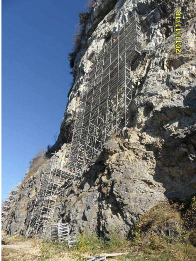
Baugerüst oberhalb der ASTRA Ölberg-Galerie
