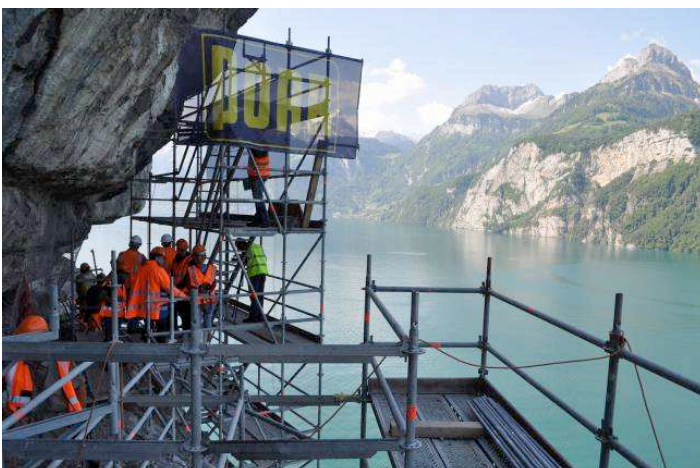
Der Presstross auf dem Gerüst
