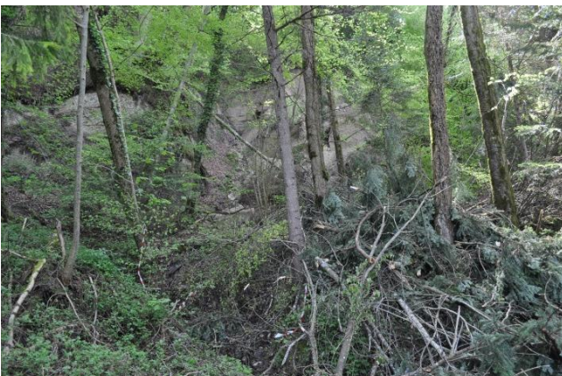
Der Anrissbereich befindet sich im Wald und umfasst teilweise den anstehenden Fels (Obere Süsswassermolasse mit Konglomeraten, Sandsteinen und Mergeln).
