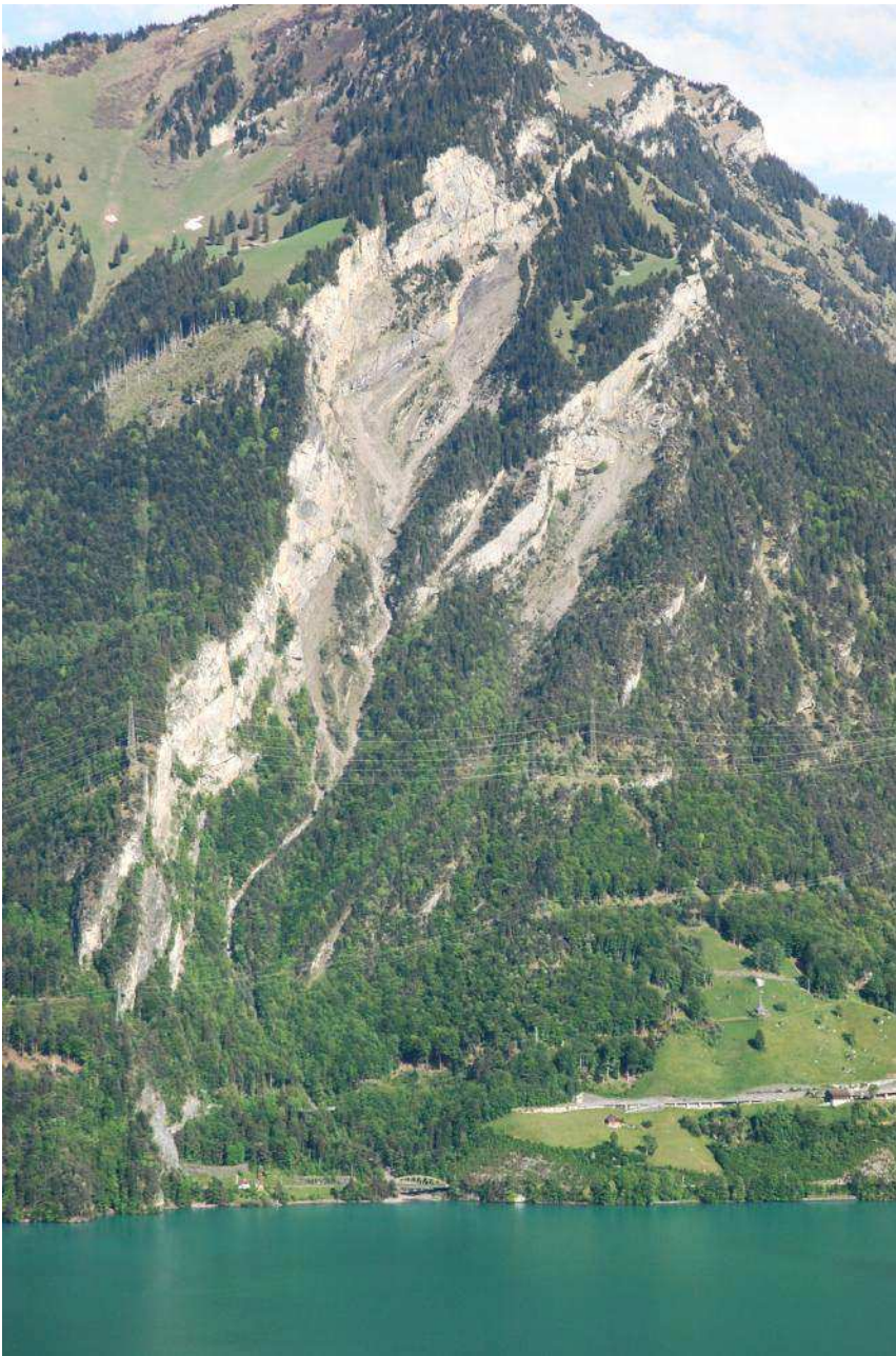
Blick vom Urnersee gegen den Berggipfel Rophaien auf den Untersuchungsperimeter Gumpischtal und Portalzone Gumpisch.
