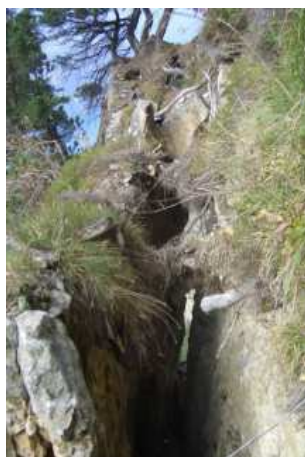
Im Gumpischtal sind mehrere grosse und weit reichende Sturzereignisse dokumentiert.
