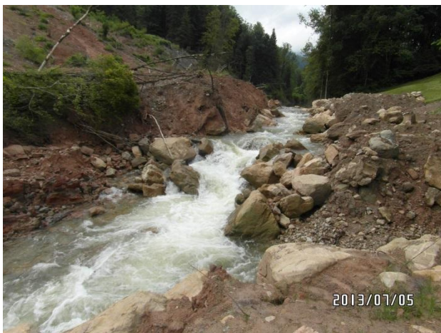
Durch die Holzguet-Rutschung (links) wird der Rümli gegen den Fuss der Roteflue-Rutschung gedrückt.
