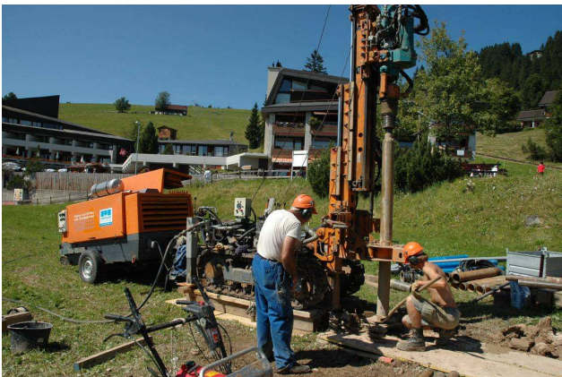
Baugrunderkundung mittels Kernbohrungen und Rammkernsondierung
