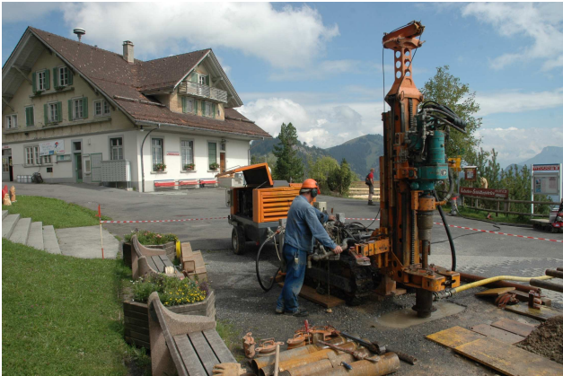
Bohrarbeiten auf dem Dorfplatz von Rigi Kaltbad
