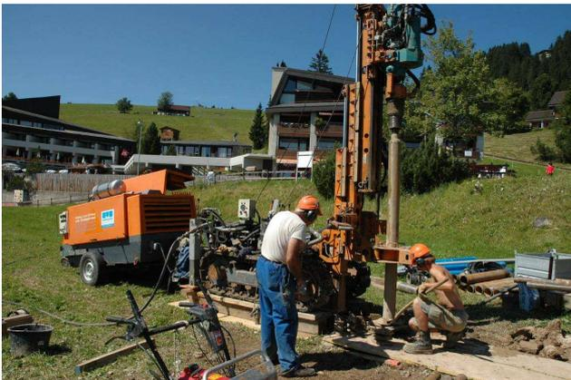
Baugrunderkundung mittels Kernbohrungen und Rammkernsondierung
