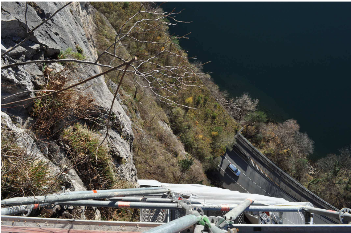
Blick vom Gerüst nach unten auf die Axenstrasse. Die Bahnlinie mit dem Nordportal des Ölbergtunnels liegt im toten Winkel.
