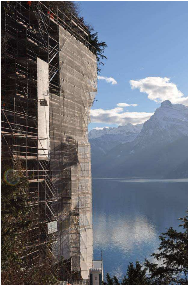
Mitte November war das Gerüst ist schon fast fertig. Gleichzeitig laufen die Vorbereitungen für die geplanten Felssicherungsarbeiten.
