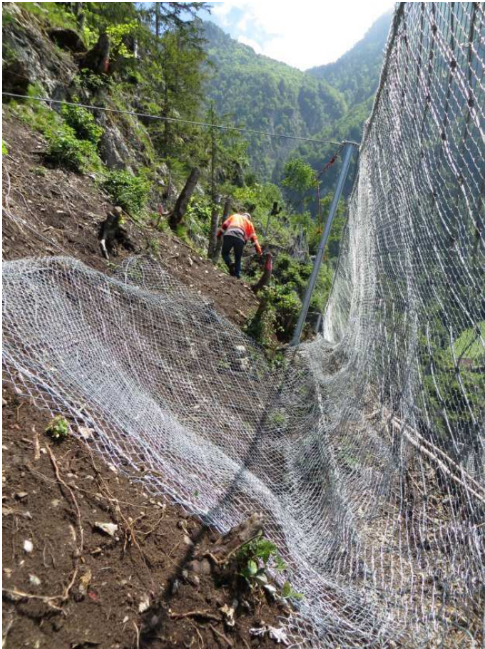
Geflechtmontage (ISOSTOP 1000 kJ, H=5 m).
