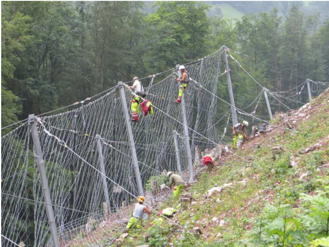
Geflechtmontage (ISOSTOP 1000 kJ, H=5 m).
