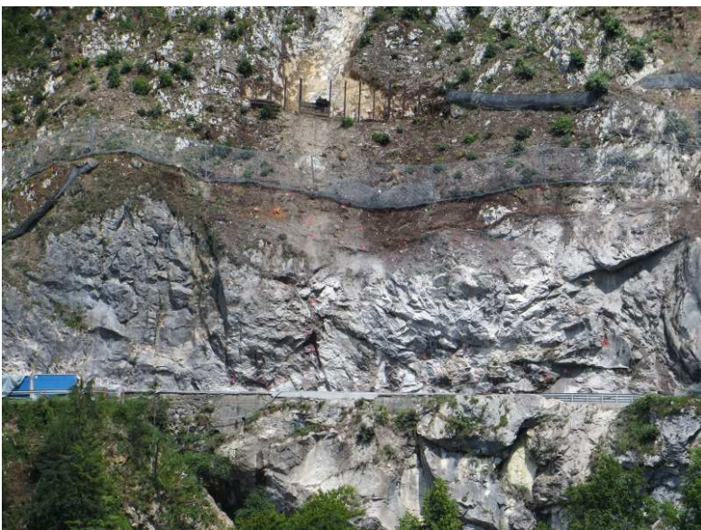
Ansicht Felsböschungsabschnitt nach den Fels-/Böschungsreinigungs- arbeiten.
