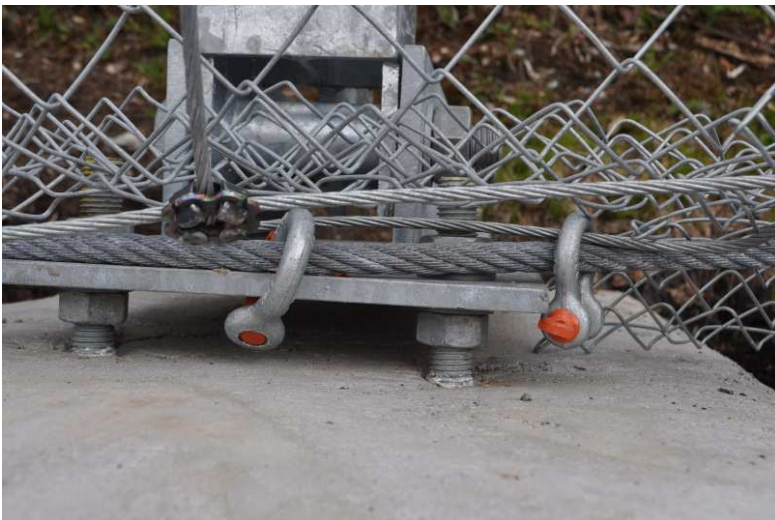
Stützenfundament (ISOSTOP 100 kJ E starr) mit M+F Stützenfussplatte.
