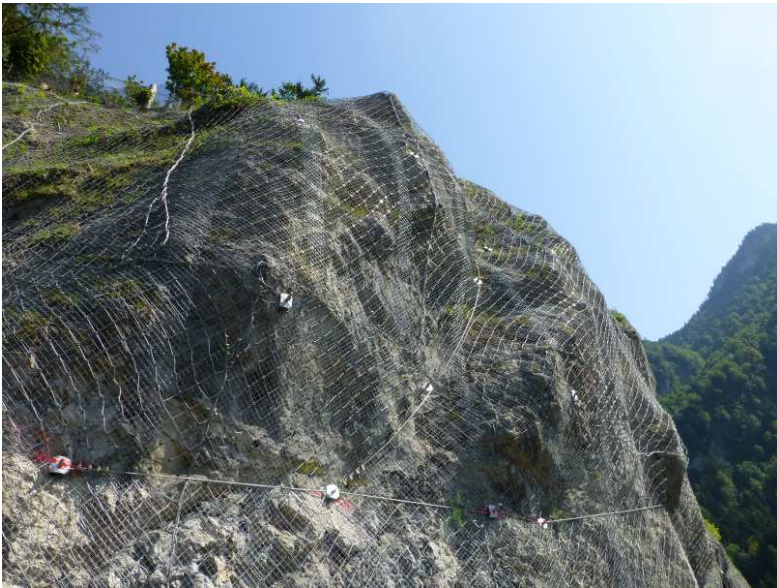
Felsabdeckung Typ 2 mit Spannseilen (ISOFIX, 150 kN/m).
