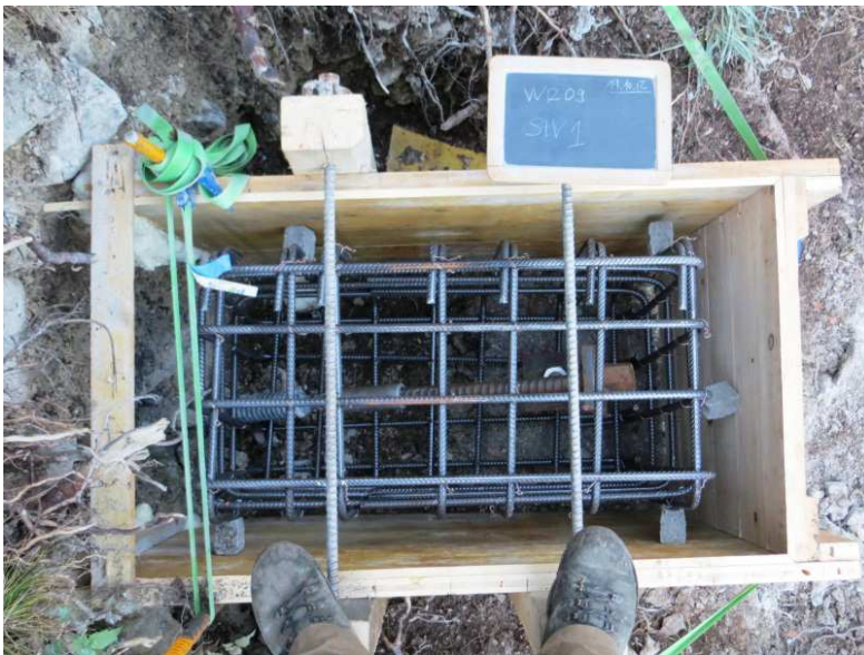
Schalung / Bewehrung Stützenfundament, Schutzstufe 2 (ISOSTOP 1500 kJ,)
