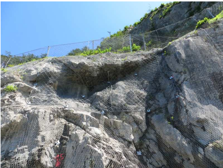
Felsabdeckung Typ 3 (ISOFIX, 220 kN/m) im stark zerrütteten Felsbereich umgeben von Felsabdeckung Typ 1.
