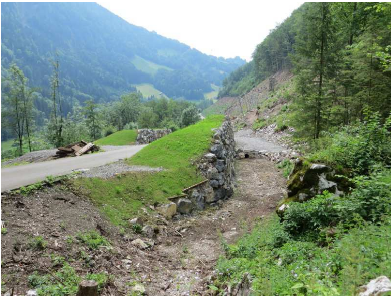
Begrünte Steinschlagschutzdämme ( E < 3000 \text{ kJ} , H = 2\text{--}3.5 \text{ m} )
