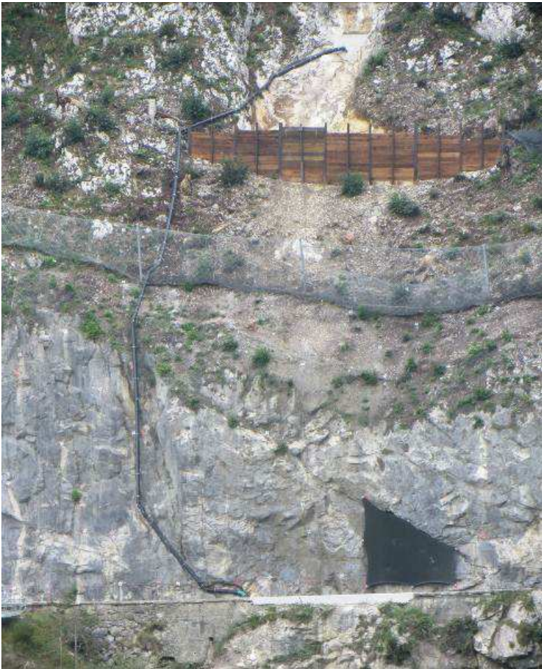
Meteorwasserableitung mit Einlaufbauwerk oberhalb der geleerten und frisch ausgefachten Holzpalisade.
