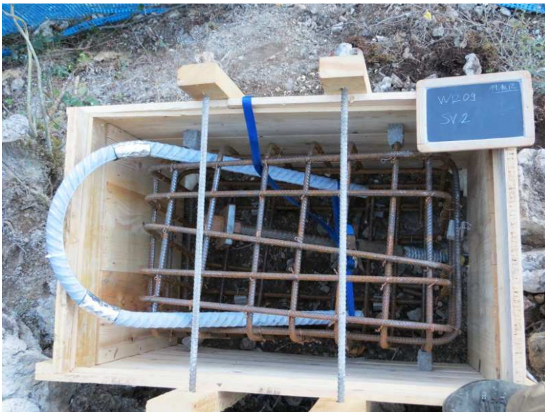
Schalung / Bewehrung Seitenfundament, Schutzstufe 2 (ISOSTOP 1500 kJ).
