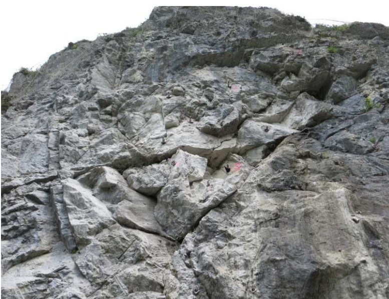
Felssicherungsarbeiten (SoMa) nach der Felsreinigung
