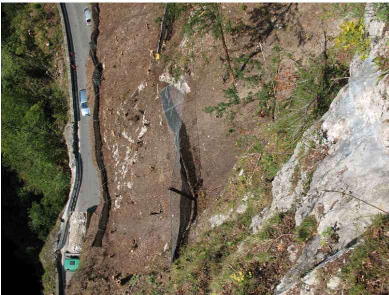
Kontrolle der Fels-/ Böschungs- reinigungsarbeiten am hängenden Seil.
