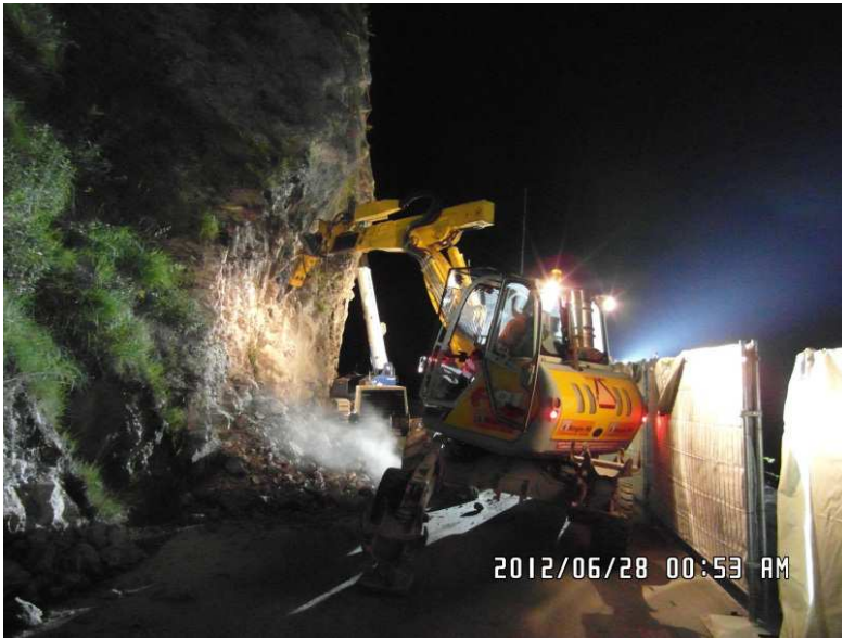
Felsabtrag zur Anpassung des Strassenlichtraumprofiles am geplanten Strassenausbau (unter Totalsperrung in der Nacht).
