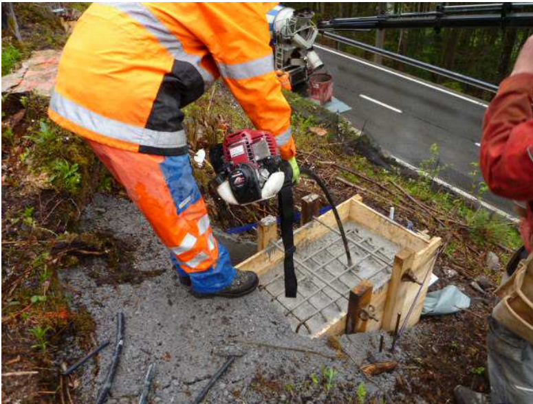
Betonarbeiten für Stützenfundamente
