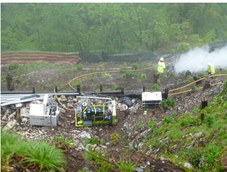
Bohrarbeiten zur Verankerung eines Steinschlagschutzwerkes (250 kJ) mit temporären Abrollschutz- massnahmen.
