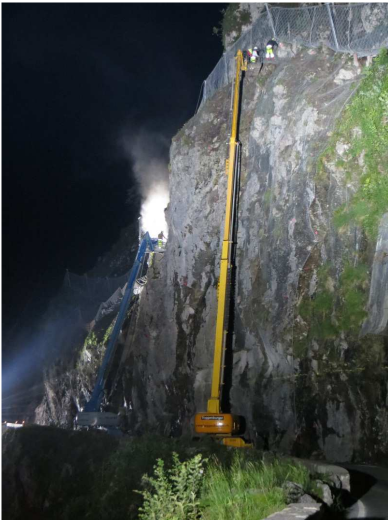
Bohr- und Verlegearbeiten für die Felsabdeckung Typ 1 (40 kN/m) im Bereich der Felsböschung Horäränk (unter Totalsperrung in der Nacht)
