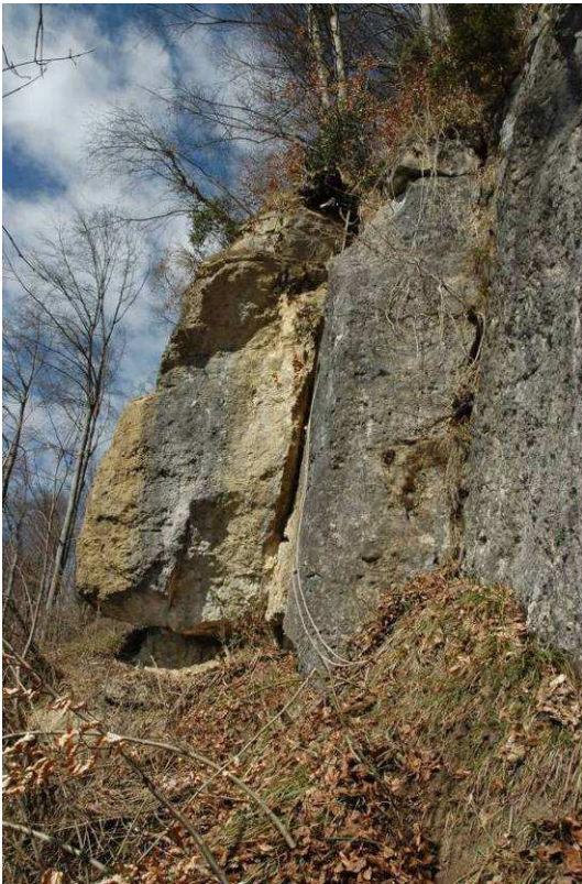
Ansicht des unterschrittenen Felspaketes von Osten. Zustand vor der Sprengung
