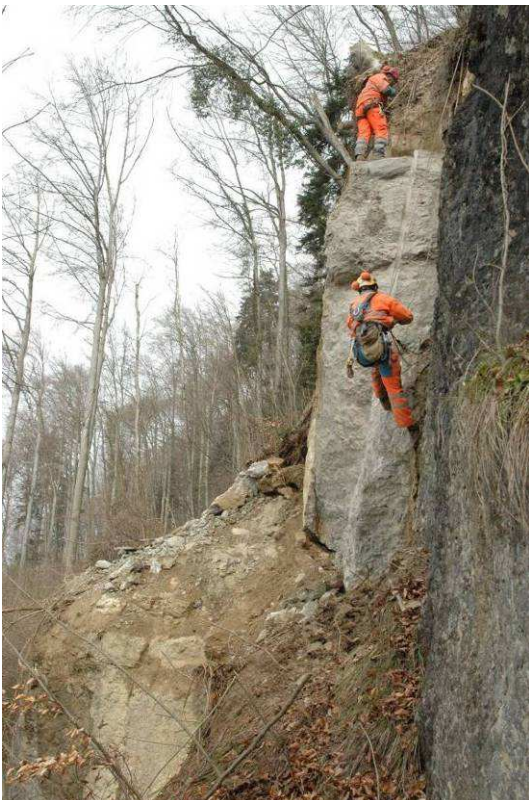
Zustand nach der Sprengung
