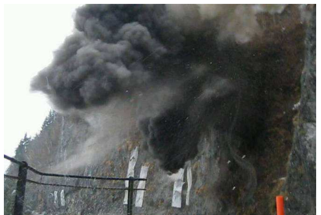
Sicherheitssprengung eines Überhanges (Einzelbilder aus einer Videoaufnahme)
