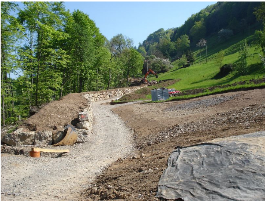
Abbildung 2: Stand Anfang Mai, die Arbeiten sind bereits gut vorangeschritten
