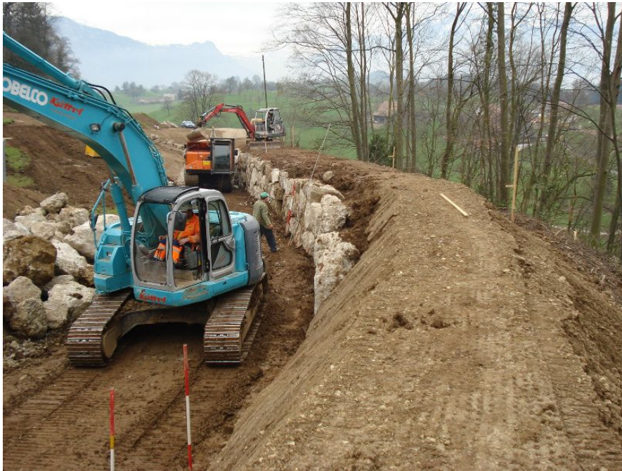
Einbau der Blocksatzlagen
