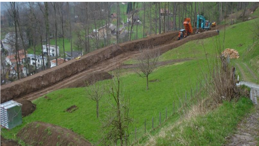
Blick von oben auf den im Bau befindlichen Damm und den Rückhalteraum
