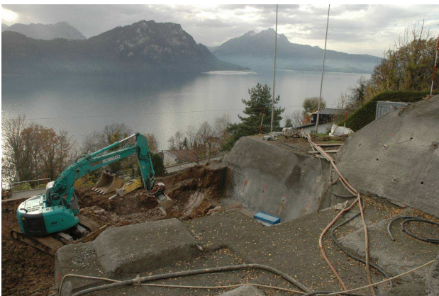
Westlicher Teil der Baugrube, während der Aushubarbeiten. Blick Richtung Bürgenstock / Pilatus
