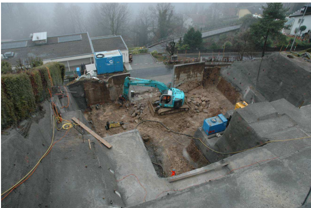
Letzter Schliff kurz vor Fertigstellung der Baugrube
