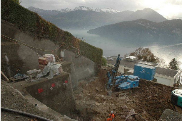
Östlicher Teil der Baugrube, während der Aushubarbeiten. Blick Richtung Ennetbürgen
