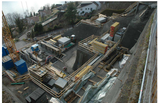
Ende März 2010: Es wird fleissig gebaut.
