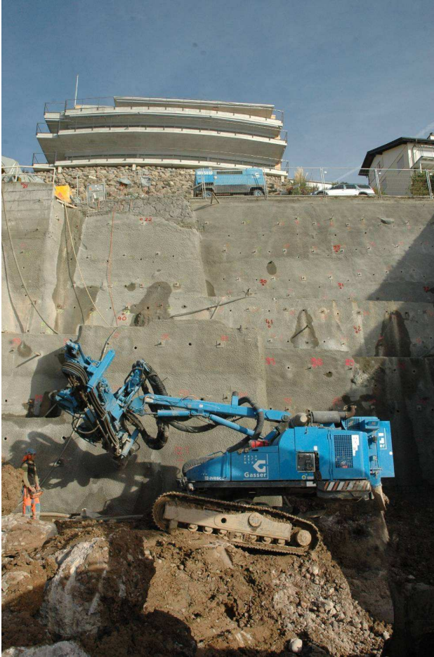
Das Ankerbohrgerät der Fa. Gasser Felstechnik im Einsatz. Insgesamt wurden weit über 100 Bodennägel verbaut.
