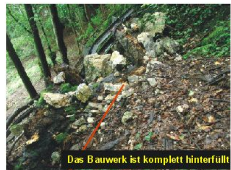
Die Querelemente sind verbogen/zerrissen und rosten
