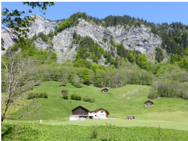
Gefahrenquelle Sturzprozesse: Die Gebäude am Hangfuss liegen im potentiellen Wirkungsraum von grossen Blockschlägen aus den darüber liegenden Felswänden..
