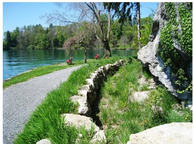
Situation Uferweg mit Abrollschutzwall nach Bauabschluss und Begrünung (Foto vom 24.04.2015).
