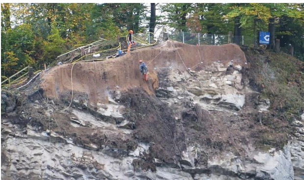
Absturz- und Böschungssicherung „Viktoria-Platz“ (Foto vom 31.10.2013).
