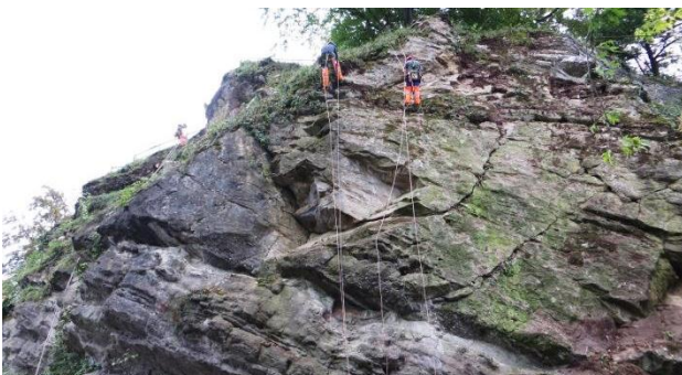
Felsreinigungsarbeiten am hängenden Seil (Foto vom 02.10.2013).
