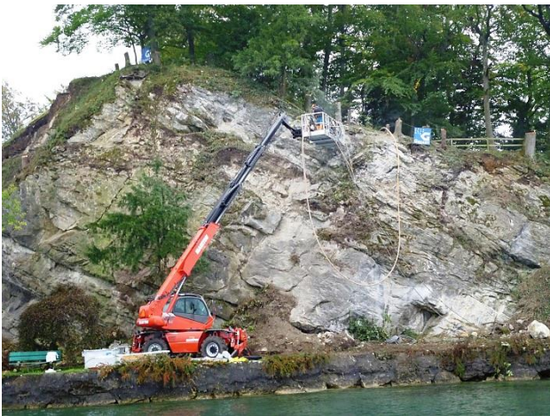
Bohrarbeiten von der Hebebühne (Foto vom 09.10.2013, R. Muggli).
