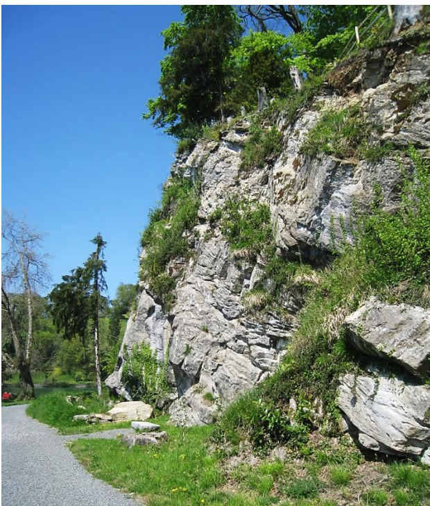
Situation nach Bauabschluss (Foto vom 24.04.2015).
