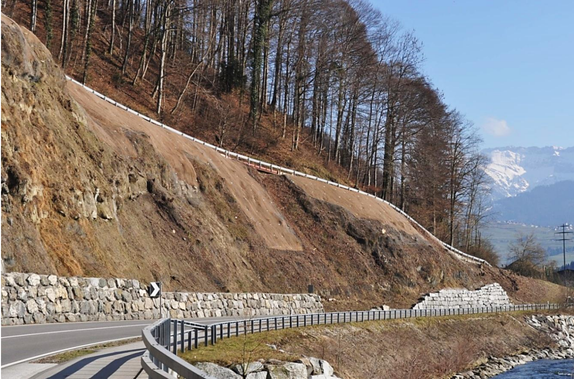
Ergänzende Schutzmassnahmen direkt nach deren Erstellung; Foto vom 20.02.2014.
