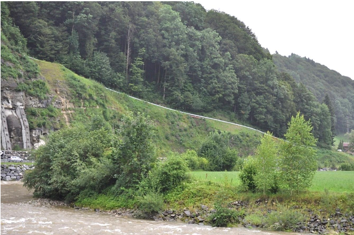
Im Sommer 2014 ist der Hang bereits wieder begrünt und die Hangsicherungen sind von Weitem kaum noch sichtbar; Foto vom 10.07.2014.
