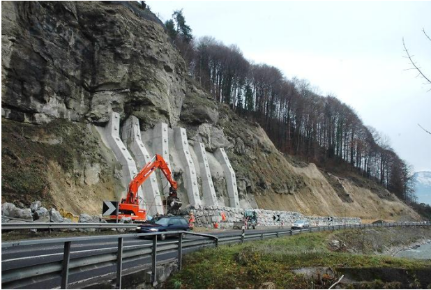
Situation nach Abschluss der Sicherungsarbeiten im Hangbereich aufgenommen im Jahr 2007.
