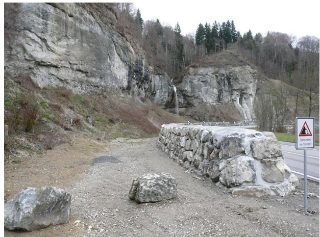
Ausführung und fertiges Bauwerk der Dammerweiterung im Februar 2015.
