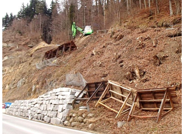
Temporäre Schutzmassnahmen für die K10 während der Sicherungsarbeiten im 2014.
