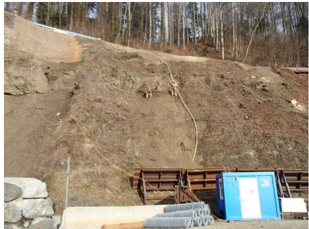
Vorbereitungsarbeiten für die Montage der Erosionsschutznetze im Jahr 2014.
