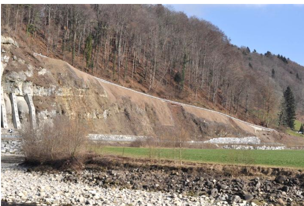
Situation nach Abschluss der Sanierungsmassnahmen im Februar 2014.
