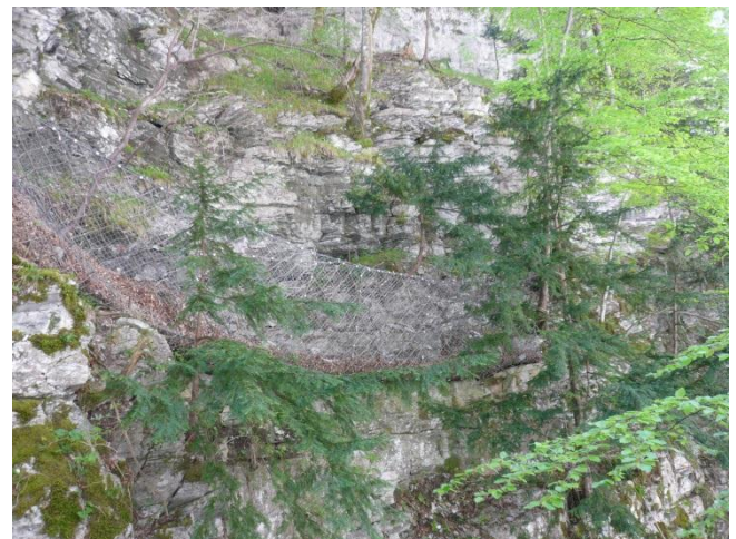
Bestehendes Steinschlagschutznetz im oberen Felswandbereich, aus welchem die Hinterfüllung mit Laub, Ästen und Steinen im Rahmen der ausgeführten Arbeiten vollständig entfernt wurde.
