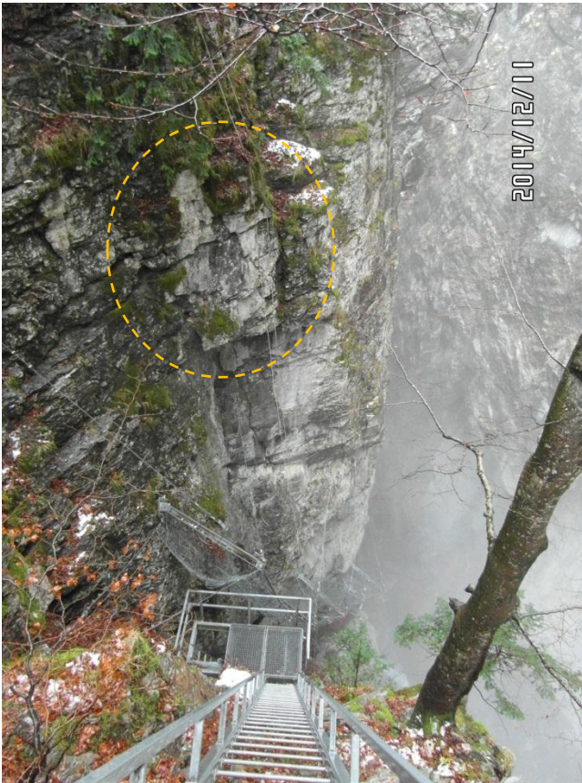
Oberhalb des Zugangssteigs befindet sich eine stark geklüftete, überhängende Felsnase (Kreis), an welcher bereits 2014 Rissriegel angebracht wurden.
