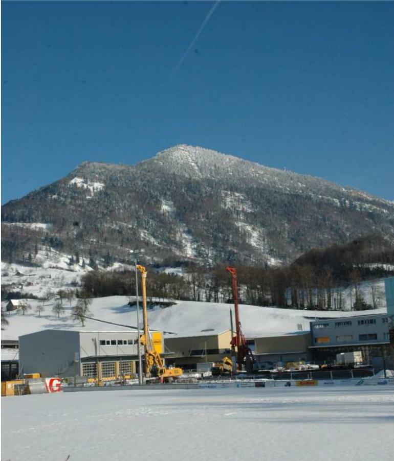
*Es wurden 2 Grossbohrpfahlgeräte der Fa. Eggstein eingesetzt, um insgesamt 169 Ortbeton-Grossbohrpfähle mit 880 mm, bzw. 640 mm Durchmesser zu erstellen (Fotos November/Dezember 2012).*
