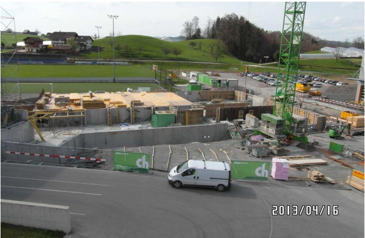
Die Bodenplatte ist gegossen und die Seitenwände sind weitestgehend erstellt. Sobald der Gebäuderohbau schwer genug gegen Auftrieb, wird die Wasserhaltung eingestellt (April 2013).
