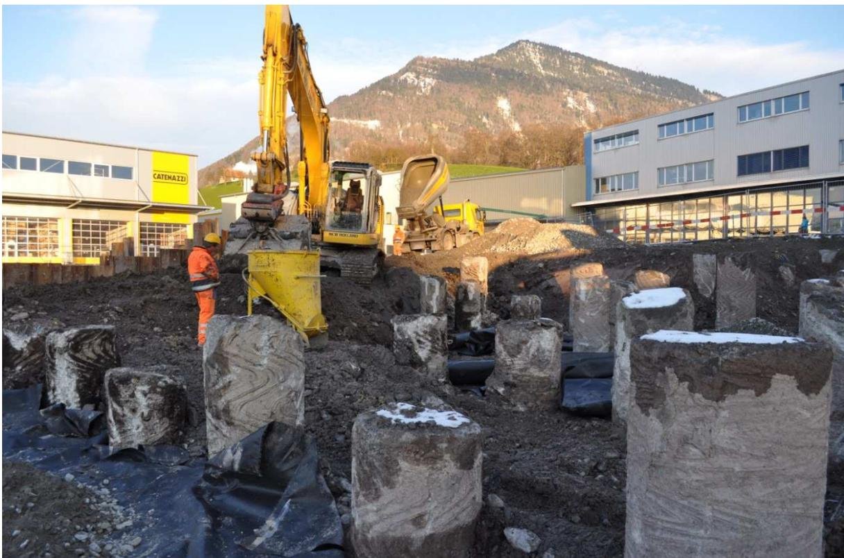
*Nach Beendigung der Pfählungsarbeiten wurde die als Bohrplanum benützte ehemalige künstliche Auffüllung ausgehoben und abgeführt.*
