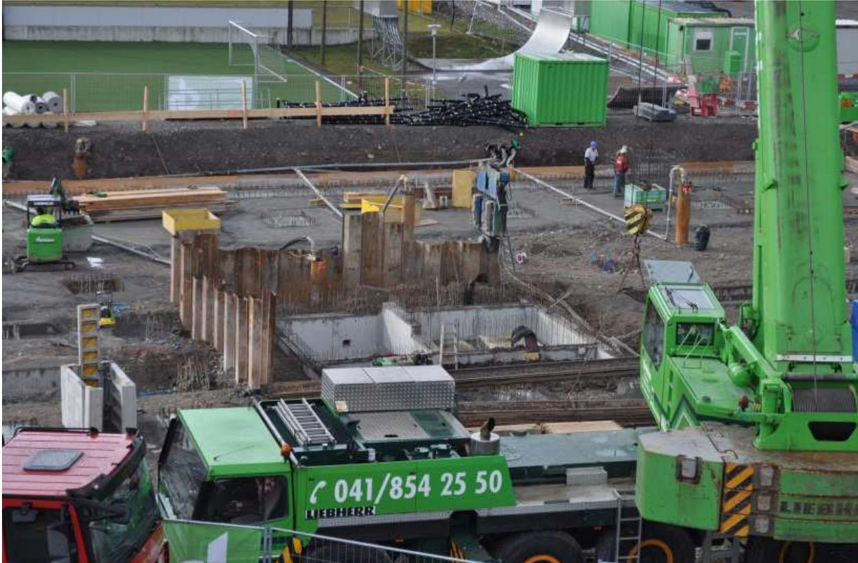
*Für Liftunterfahrten und Pumpenschächte wurde ein geschlossener Spundwandkasten erstellt, da hier die Aushubtiefe weit unterhalb des grundwasserstauenden Seekreide-Horizonts reichte (Januar bis März 2013, Bild vom Ausvibrieren der Larssen).*
