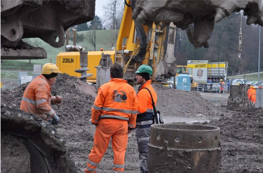
*Die Pfählungsarbeiten erfolgten stets in enger Zusammenarbeit zwischen Bohrteam und Geologe. So konnte stetig das Baugrundmodell verifiziert und gegebenenfalls angepasst werden, um passgenaue Arbeit zu gewährleisten (Foto Dezember 2012).*
