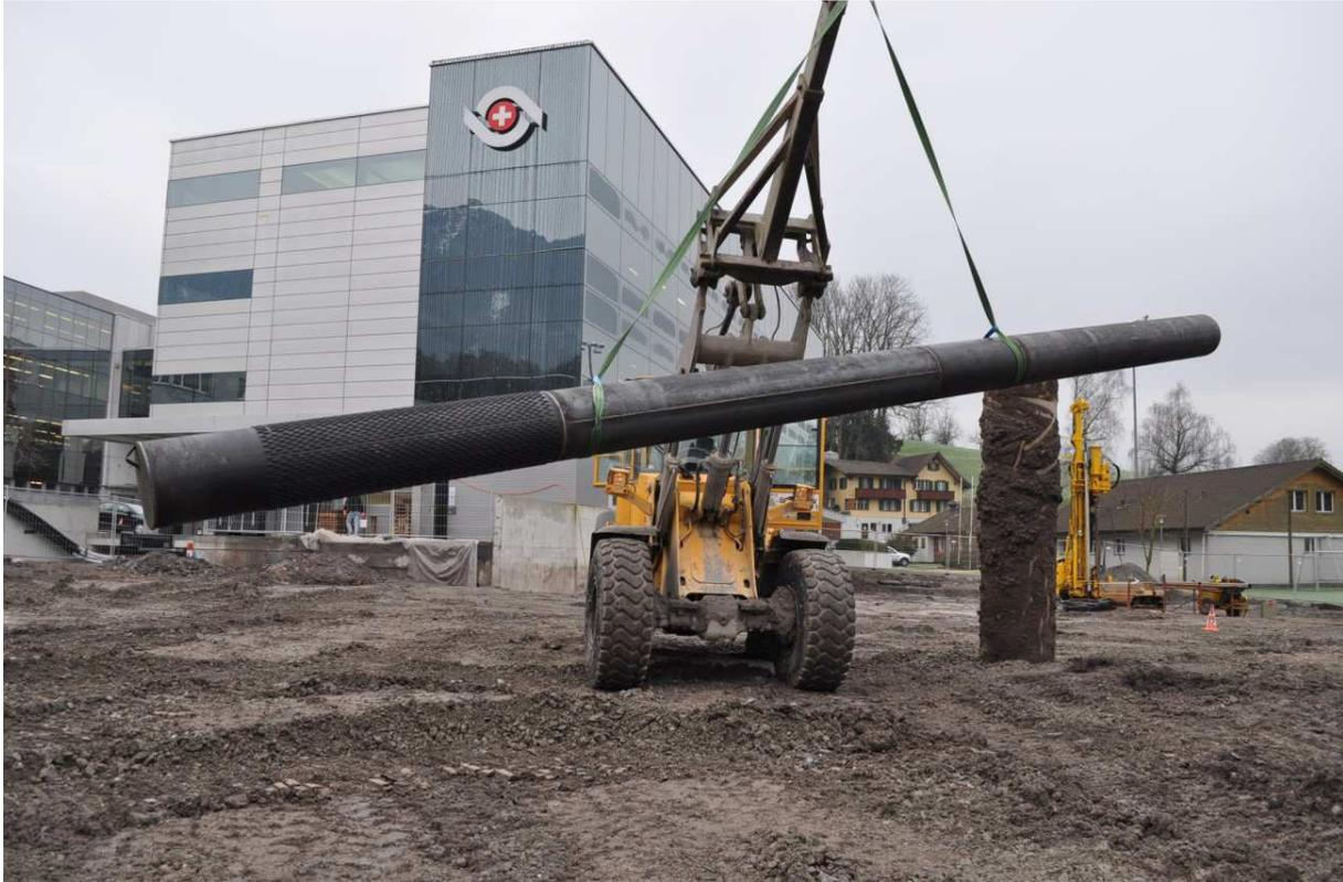
*Insgesamt 9 vorgefertigte Filterbrunnen ( $\varnothing$  400 mm) wurden eingebaut, um das bis über das Fundationsniveau gespannten Grundwasserdruckniveau möglichst lokal und schonend zu entspannen (Dezember 2012).*
