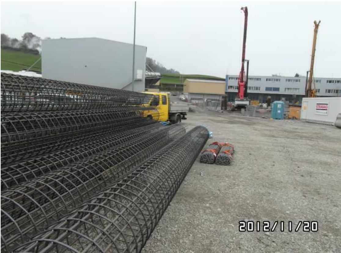
*Die Bewehrungskörbe wurden in standardisierter Länge angeliefert und vor Ort auf die benötigte Länge zurechtgeschnitten. Dieses Verfahren ermöglichte eine zügige und flexible, auf die geologischen Gegebenheiten abgestimmte Anfertigung der Bohrpfähle (Nov. 2012).*
