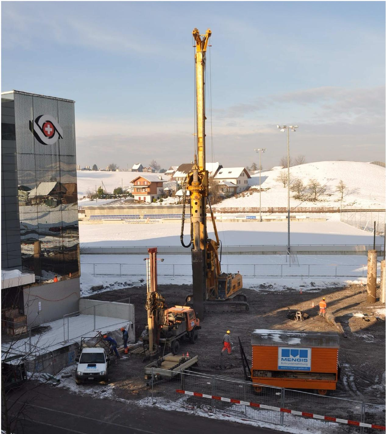
*Während der Bohrpfahlarbeiten mussten kurzfristig weitere Rotationskernbohrungen in den Arbeitsfluss integriert werden, nachdem bei den Pfahlarbeiten in einem sensiblen Bereich der Bauparzelle unvorhergesehener Weise ein stark entfestigter Mergel angetroffen wurde (Dez. 2012).*
