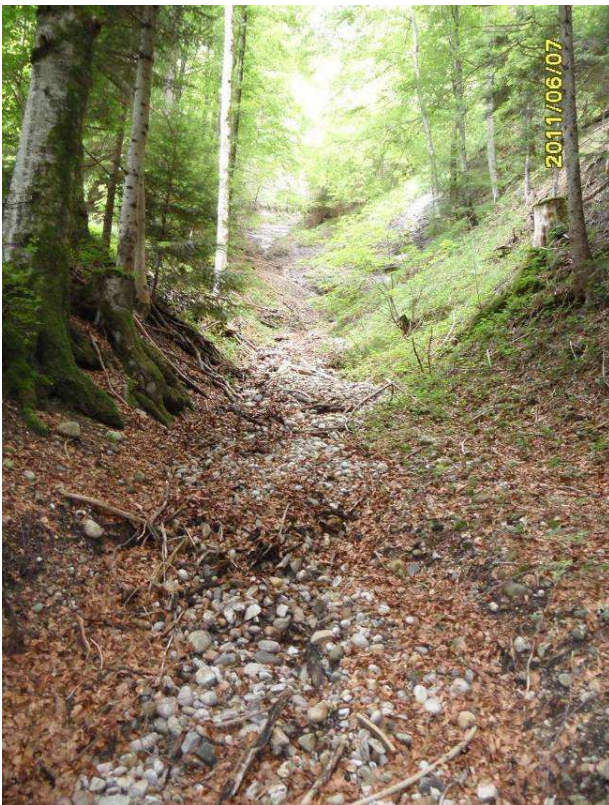
Herausgewitterte Nagelfluh-Gerölle werden in die zahlreichen Runsen im Gebiet Ilfisfluh abgelagert und bei starken Niederschlägen auf die Kantonsstrasse geschwemmt.
