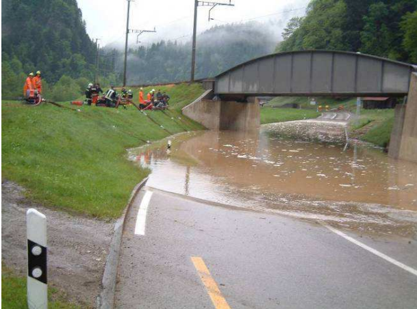
Die SBB-Unterführung bei Kröschenbrunnen wird bei Unwettern regelmässig mit Wasser und Geschiebe gefüllt (vif).
